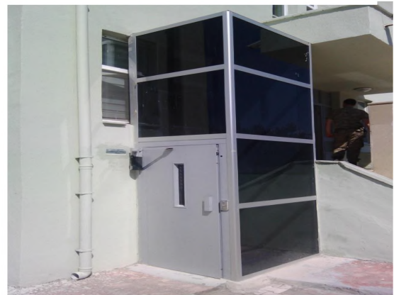
Hizmet Binalarının Engellilerin Kullanımına Uygun Hale Getirilmesi
