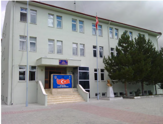
Hizmet Binaları Dış Cephe Yalıtımı Yapımı
