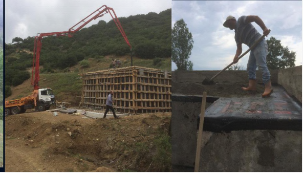
İçme Suyu Depo Yapımı
